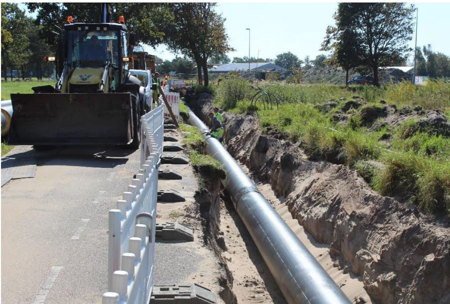
Hovedledningen langs cykelstien på Skagensvej.
