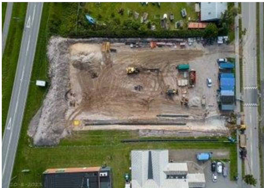
Byggepladsen som den så ud den 10. aug. 2023
